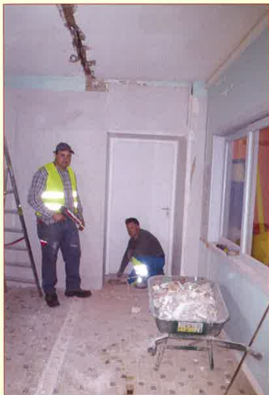
Les ouvriers communaux s'apprêtent à poser des dalles dans la cuisine de l'accueil périscolaire
