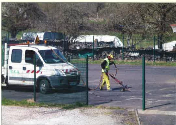
**Aire de jeux multisports :** Traitement des fissures par injection d'émulsion de goudron : 3713 €
