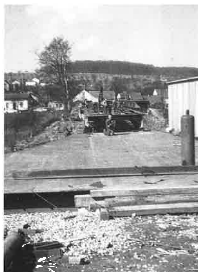
Construction du pont de la Sarre
