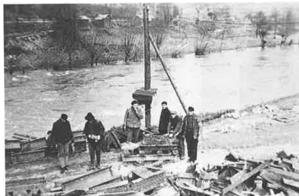
Reconstruction du pont SNCF "WIEDERAUFBAU"
