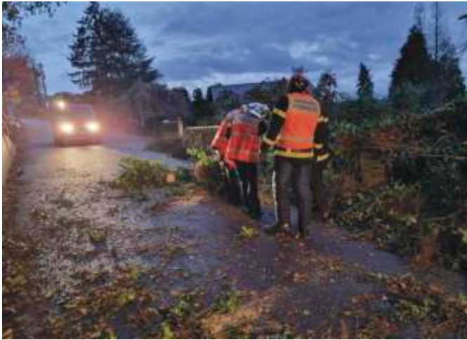
Intervention rue de Sarreinsming suite à la chute d'un arbre un jour de grand vent.
