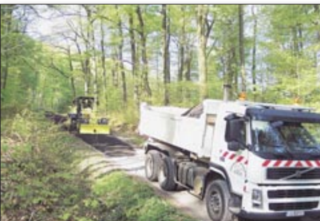
Rechargement du chemin forestier «in den Roedern» et du chemin rural «Hinter dem Langenberg» Coût : 3 564 € HT Coût : 1 000 € HT
