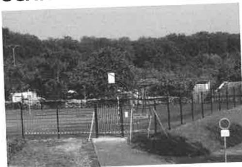
Le grillage du plateau EPS défoncé a été remplacé par un grillage plus solide et rigide.
