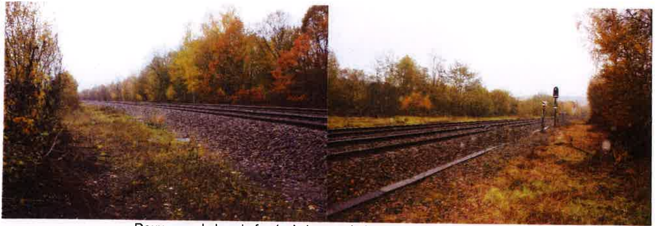
Deux vues de la voie ferrée à deux endroits différents distants de 650 m, il n'y a ni clôture ni structure fortement infranchissable
