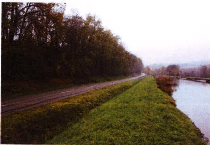
Vue de l'ensemble route (franchissable) et canal (la voie ferrée et sur la butte à gauche). Le canal a ici des berges inclinées en béton avec des parties végétalisées franchissables.
