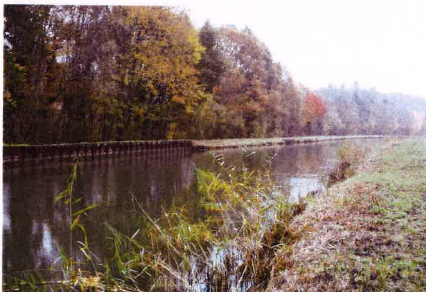
Vue du canal avec une portion en palle-planches infranchissables et une portion où elles ont été arasées donnant naissance à des berges inclinées, végétalisées et franchissables
